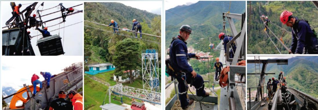
Los trabajos de mantenimiento preventivo contemplaron el corte y tensado de la guaya tractora, que moviliza a la cabina del segundo y tercer tramo (entre la estación La Montaña y La Aguada).
